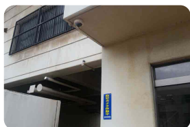
防犯カメラ設置 (水島西千鳥町)
