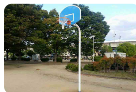
水島寿町公園 バスケットゴール新設 (水島東寿町)
