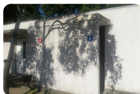
水島緑地福田公園 トイレ照明改修 (福田町古新田) トイレが暗いため、感知式の照明へ
